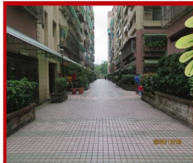
新北市深坑區新永安段 767地號
